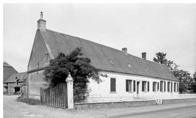
Vue d'ensemble du logis depuis le sud-est. Phot. Thierry Lefébure IVR22_19920201319Z
