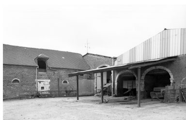
Elévations sur cour des étables et de la grange sud. Phot. Thierry Lefébure IVR22_19920201320Z
