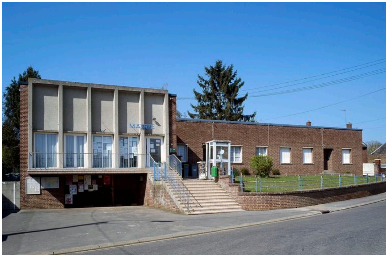
Vue générale du bâtiment de la mairie et des logements.
