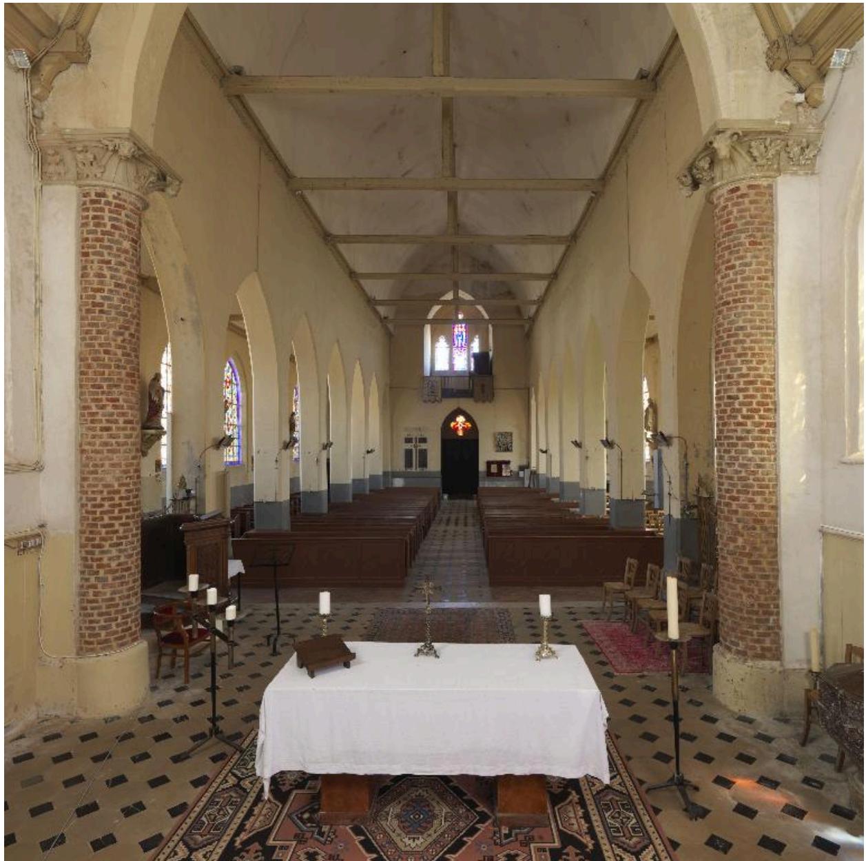
Vue de la nef depuis le chœur.
