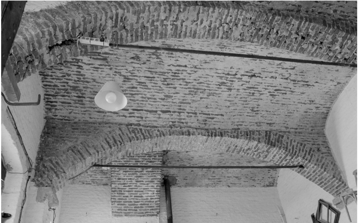
Détail des voûtes de l'étable.
