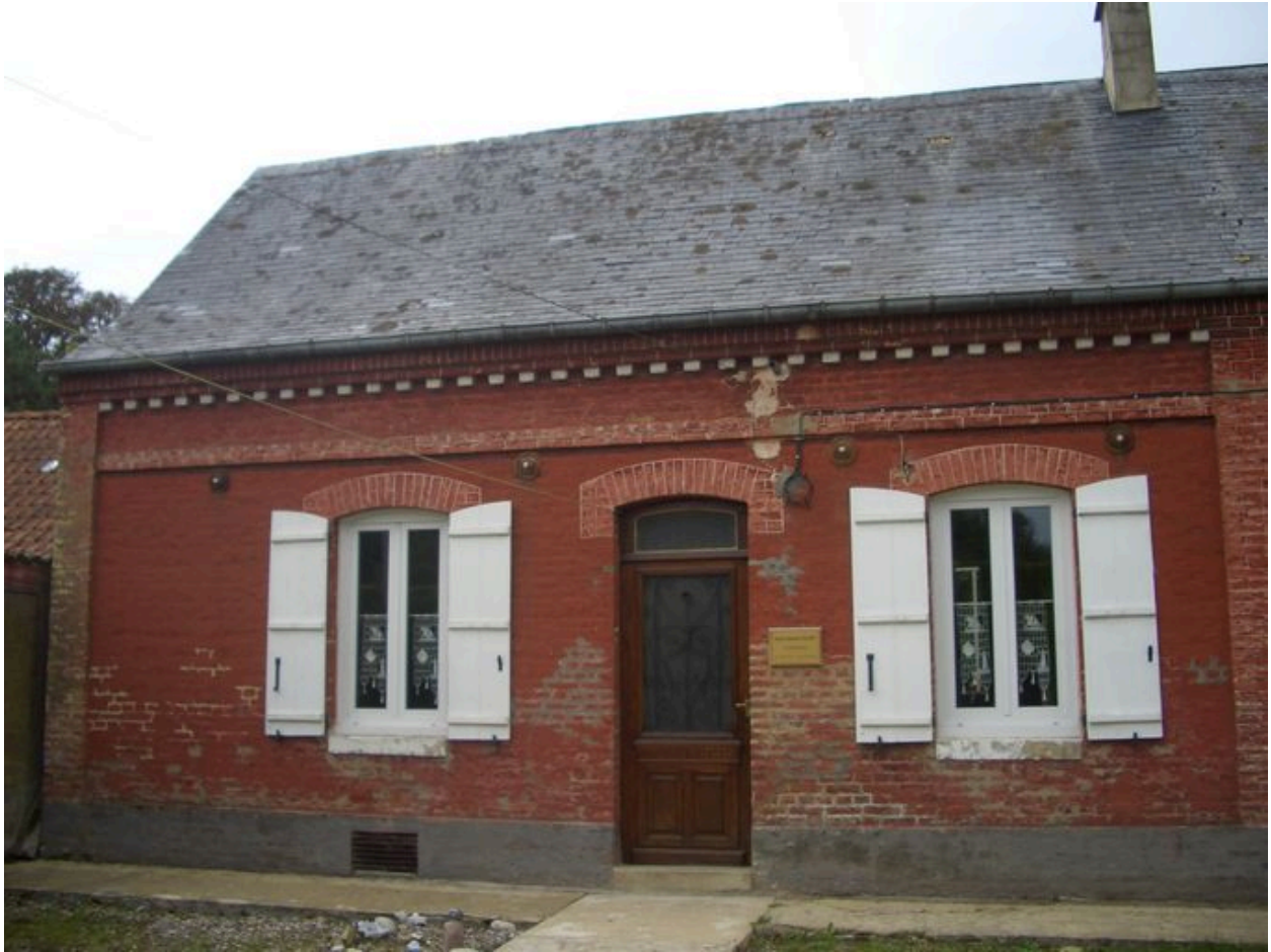
Vue de la partie habitation.
