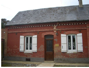
Vue de la partie habitation. Phot. Inès Guérin IVR22_20068005543NUCA
