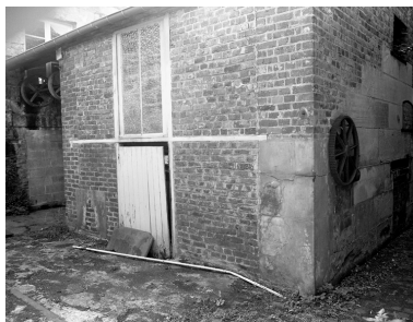
Façade nord de la salle des machines. Phot. Laurent Jumel IVR22_19966002634X
