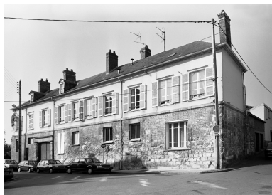
Le logement, côté rue de la Préfecture. Phot. Laurent Jumel IVR22_19966002624X
