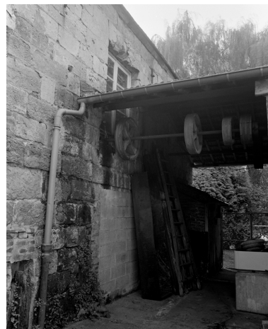
Système de poulies par courroies installé entre la salle des machines et l'atelier de fabrication en pierre de taille. Phot. Laurent Jumel IVR22_19966002635X
