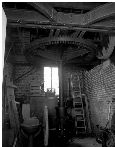
La turbine hydraulique installée en 1896. Phot. Laurent Jumel IVR22_19966002629X
