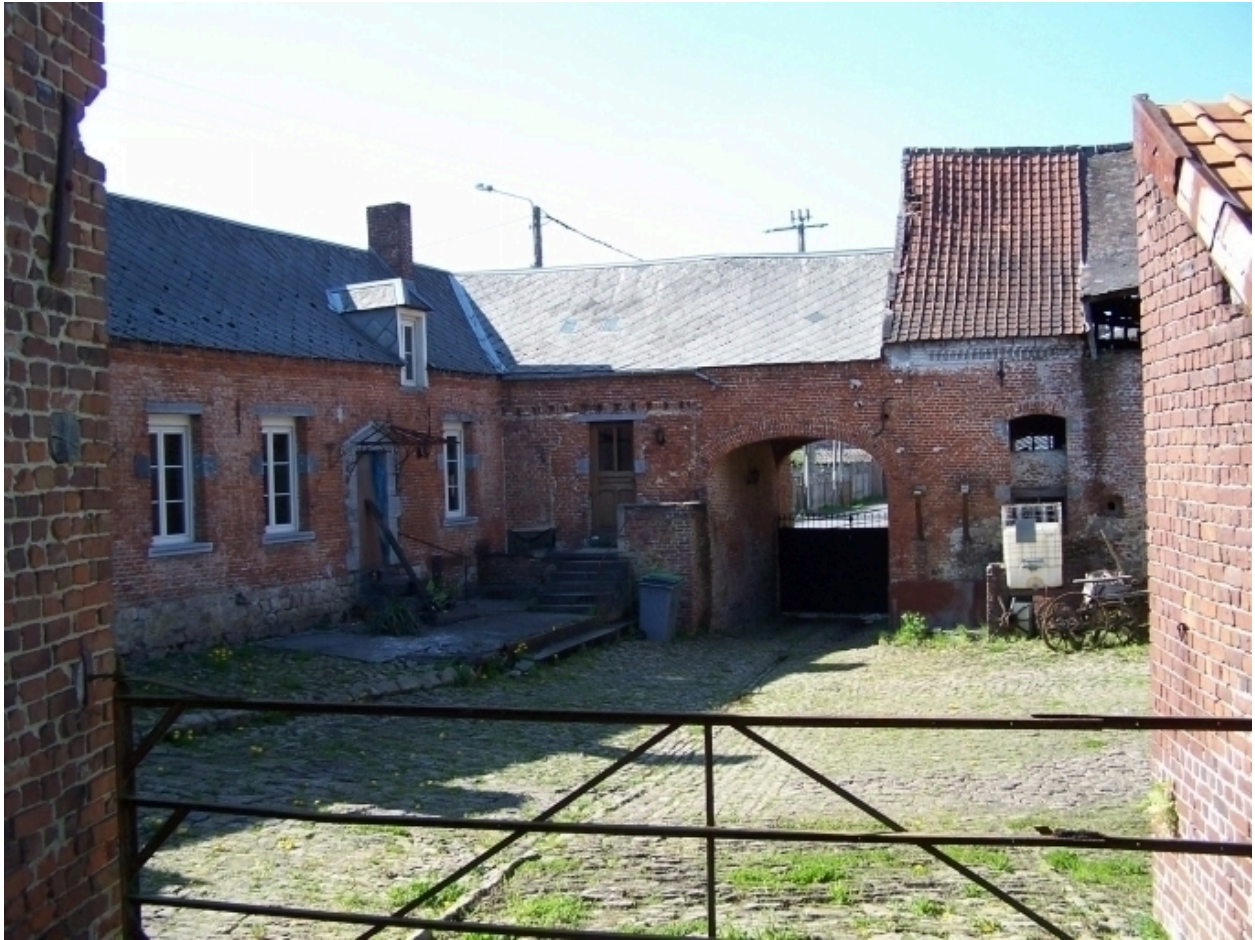
Vue de la cour de la brasserie.
