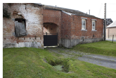
Élévation sur rue d'une partie de l'ancienne salle des cuves, du porche et du logis. Phot. Pierre Thibaut IVR31_20095903258NUCA
