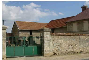
Vue des bâtiments agricoles. Phot. Inès Guérin IVR22_20030202319NUCA
