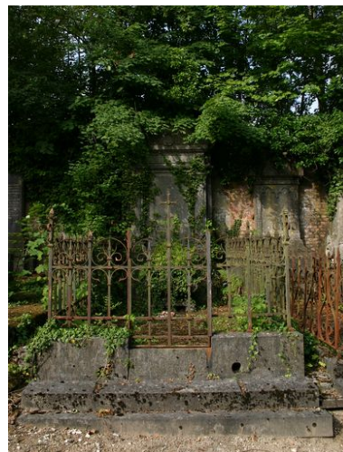
Clôture. Tambini (serrurier), vers 1884 (P 77). Phot. Caroline Vincent IVR22_20068001298NUCA
