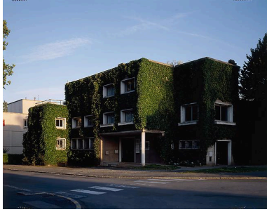
Vue générale. Phot. Thierry Petitberghien IVR31_19945901063VA
