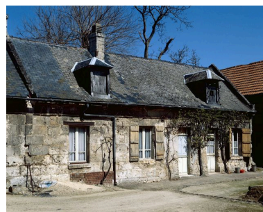
Logis. Elévation sur rue. Phot. Jean-Michel Perrin IVR22_19856000643XA
