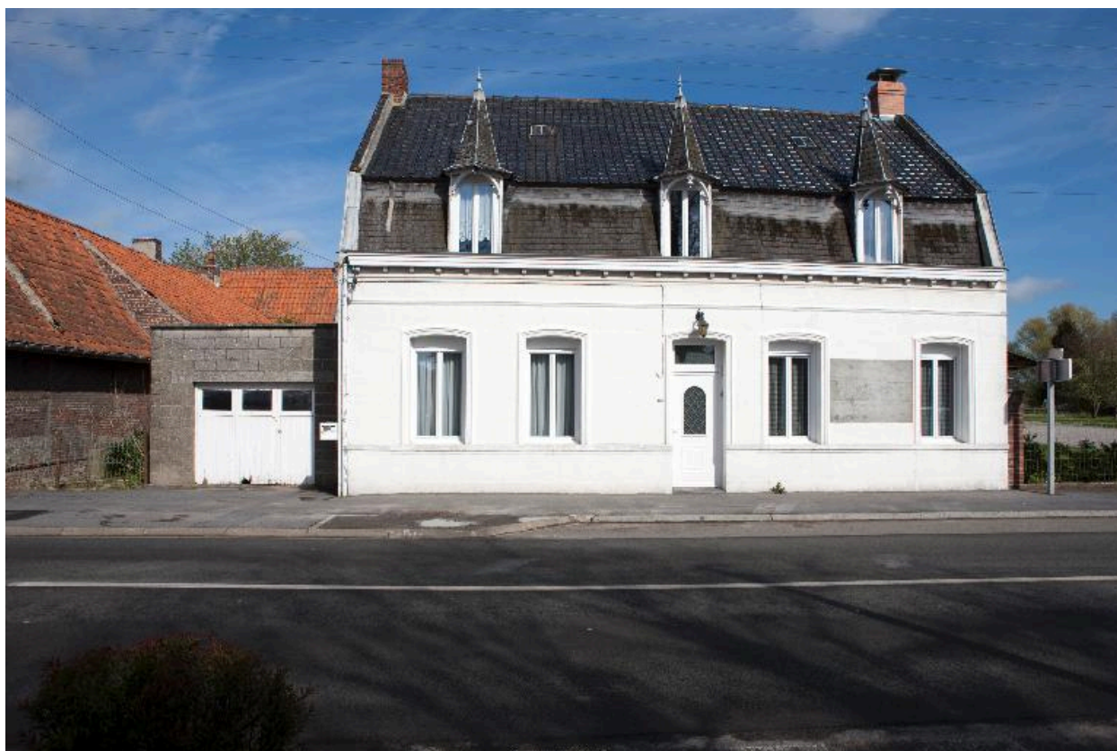
Vue générale d'une maison élémentaire avec étage de comble et lucarne à flèche.
