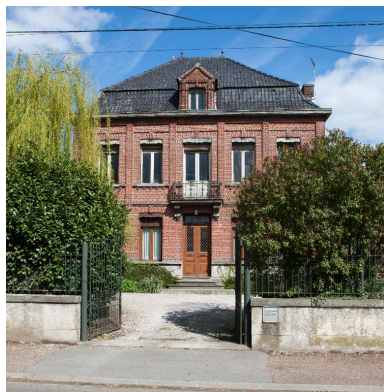
Une maison bourgeoise, 27 rue Poincaré. Phot. Pierre Thibaut IVR31_20125901644NUCA
