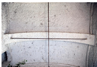
Vue générale des voûtes du pigeonnier-porche de la ferme 14 rue Poincaré. Phot. Pierre Thibaut IVR31_20125901657NUCA
