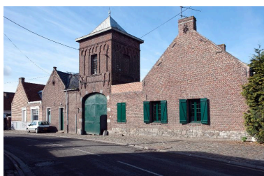
Vue générale de la ferme à cour fermée 14 et 14A rue Poincaré. Phot. Pierre Thibaut IVR31_20125901655NUCA
