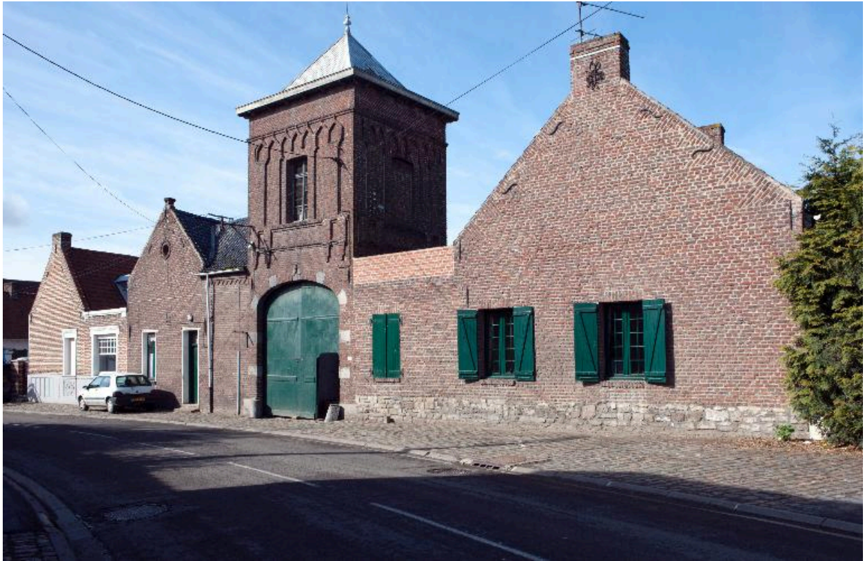
Vue générale de la ferme à cour fermée 14 et 14A rue Poincaré.
