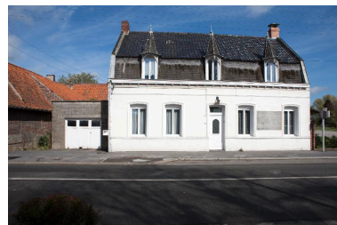
Vue générale d'une maison élémentaire avec étage de comble et lucarne à flèche.
