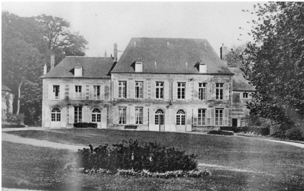
Logis. Elévation antérieure (AP).
