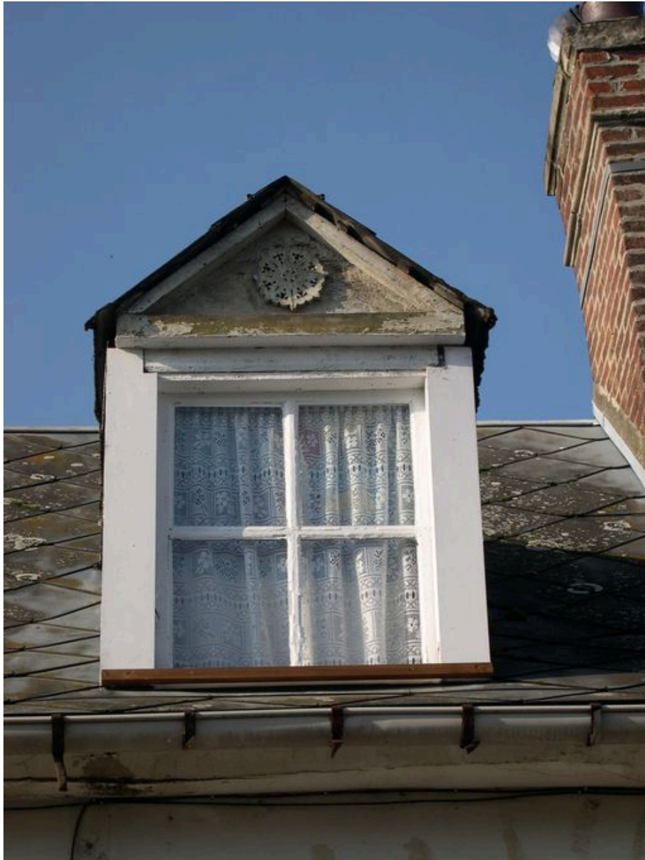
Détail sur une des lucarnes.
