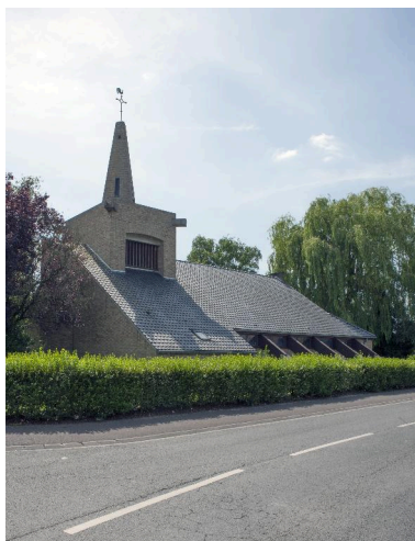
Élévation latérale gauche. Phot. Pierre Thibaut IVR31_20155900218NUCA
