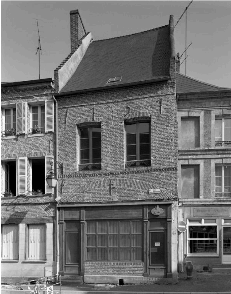
Vue de la façade sur rue.
