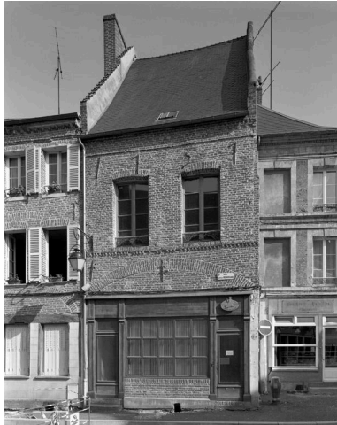
Vue de la façade sur rue.
