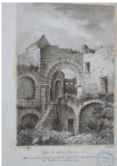
Dessin de l'église par Amédée Piette, présentant une vue de la partie comprise entre la nef et le clocher en 1859 (AD Aisne ; 8 Fi Cerny 4). Phot. Inès Guérin IVR22_20030202348NUCAB
