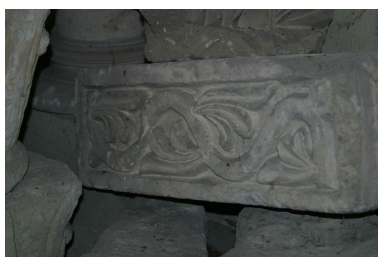
Chapiteau du dépôt lapidaire conservé dans la tribune ouest. Phot. Irwin Leullier IVR22_20050201069NUCA
