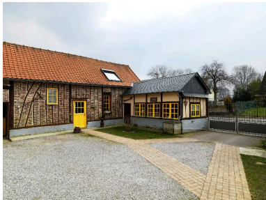
Vue générale depuis la cour. Phot. Thierry Lefébure IVR22_20138000056NUC2A
