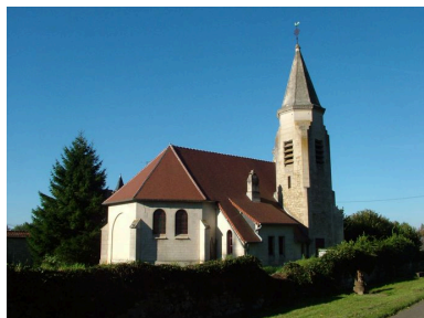
Vue du chevet. Phot. Inès Guérin IVR22_20030202450NUCA
