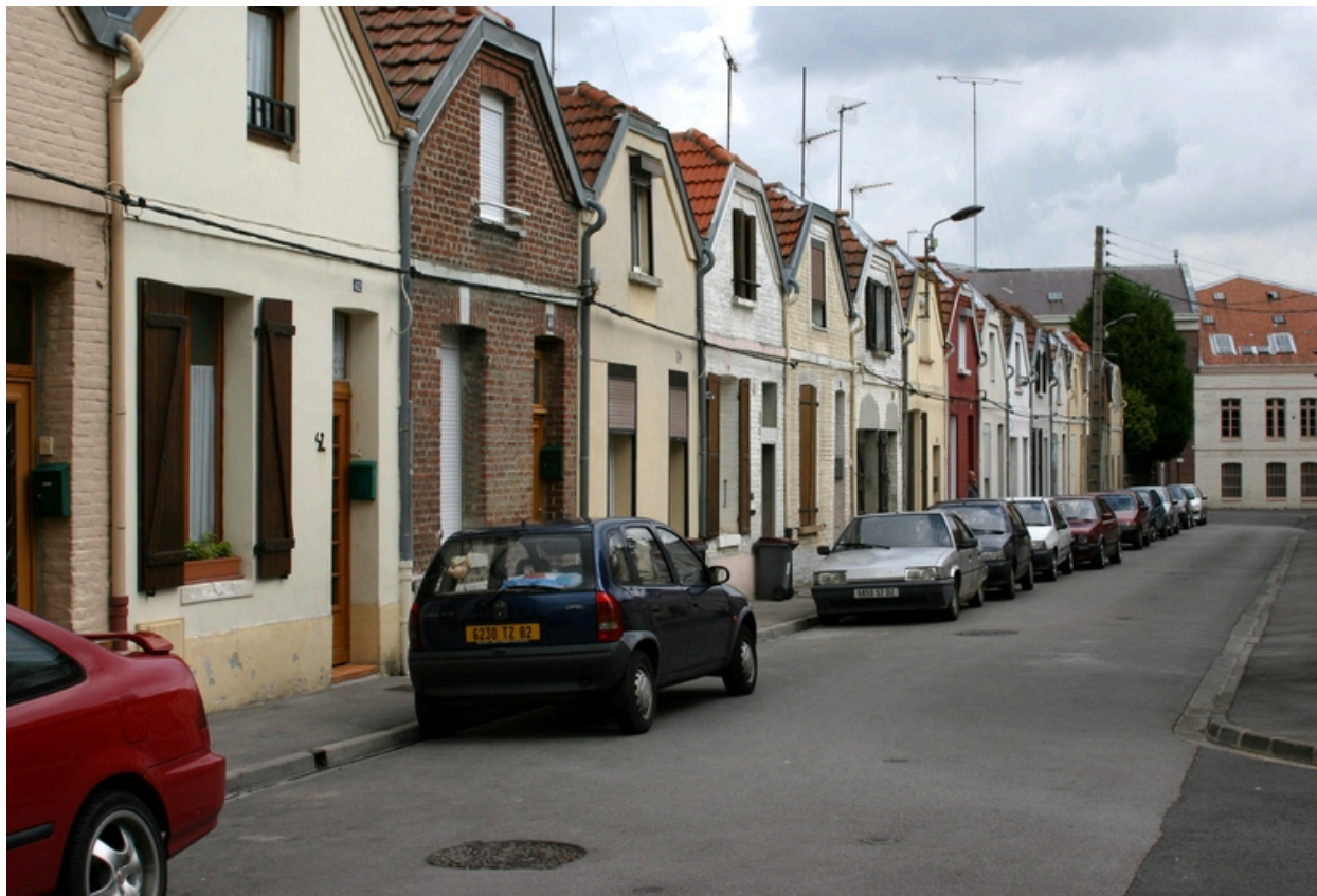
La Cité de Mulhouse : au fond, la rue de Mulhouse et l'Usine de Remicourt.
