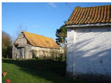
Vue de la grange. Phot. Inès Guérin IVR22_20068005630NUCA
