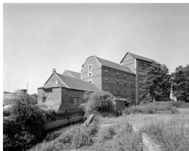
Elévations postérieures. Phot. Fabrice Charrondière IVR22_19866000100V
