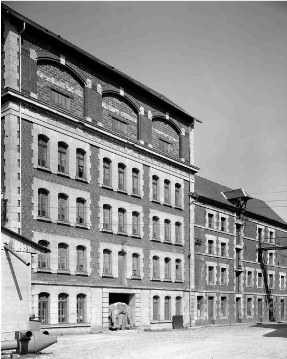
Bâtiments situés au bord de la Verse.
