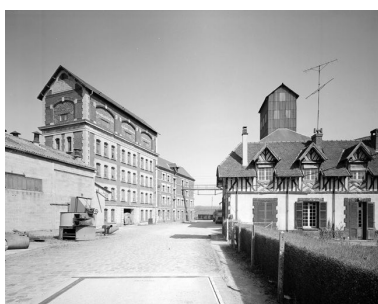
Atelier de fabrication, magasins et logement, depuis la cour. Phot. Jean-Michel Perrin IVR22_19856000582V
