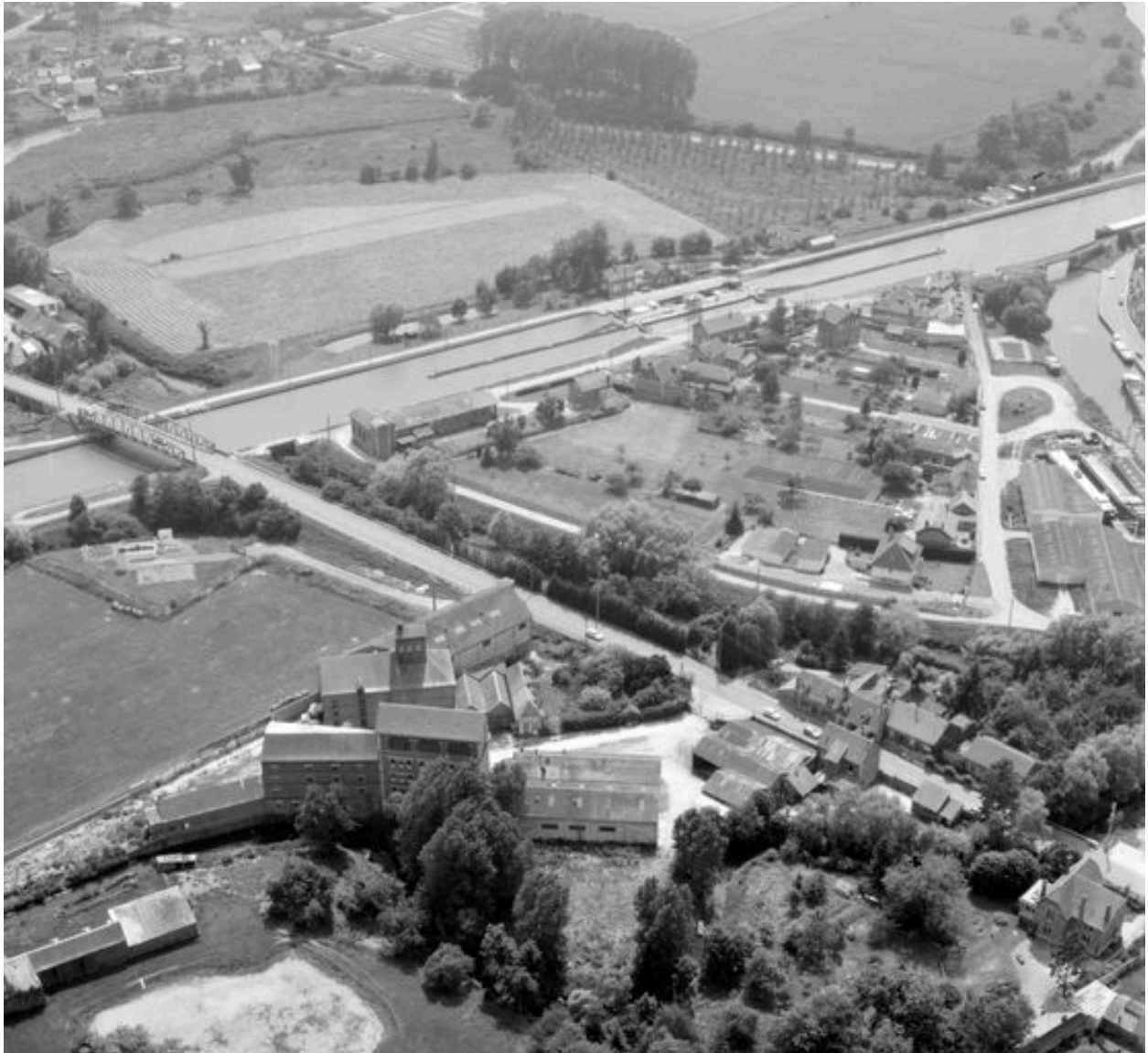
Vue aérienne de la minoterie, 1991.
