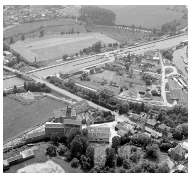
Vue aérienne de la minoterie, 1991. Phot. Phot'R IVR22_19916000217P
