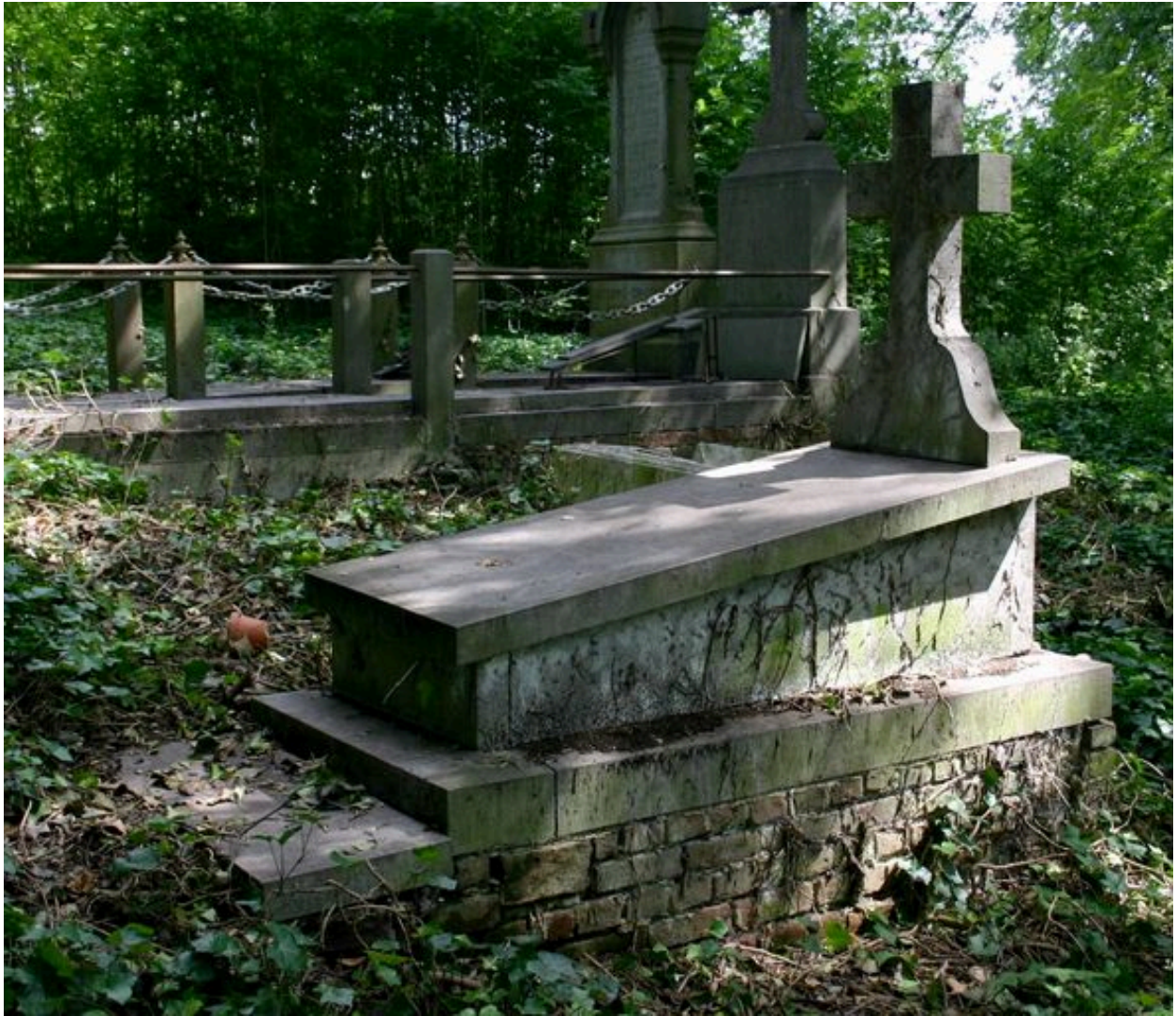
Vue générale, depuis le côté.
