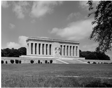
Vue d'ensemble de la face sud. Phot. Thierry Lefébure IVR22_19950200350V
