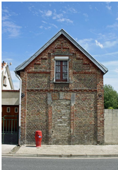
Pignon muré sur la rue. Phot. Bertrand Fournier IVR22_20098005125NUCA
