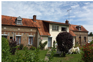
Vue d'ensemble des trois logements, façade sur jardin. Phot. Bertrand Fournier IVR22_20098005124NUCA
