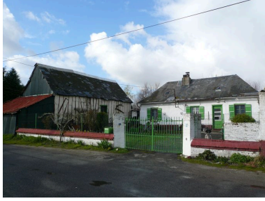
Vue générale. Phot. Inès Guérin IVR22_20078005564NUCA
