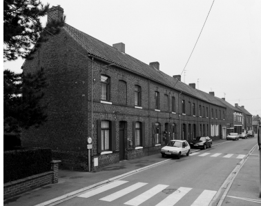
Vue générale. Phot. Philippe Dapvril IVR31_20045900679X
