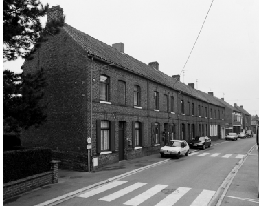
Vue générale. Phot. Philippe Dapvril IVR31_20045900679X
