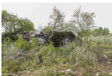
Vue vers le nord Phot. Jean-Marc Ramette IVR31_20145904294NUCA
