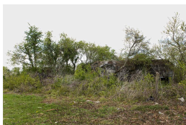
Vue vers le Sud-Ouest Phot. Jean-Marc Ramette IVR31_20145904300NUCA
