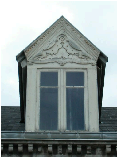
Détail d'une fenêtre de lucarne. Phot. Elisabeth Justome IVR22_20058003082NUCA
