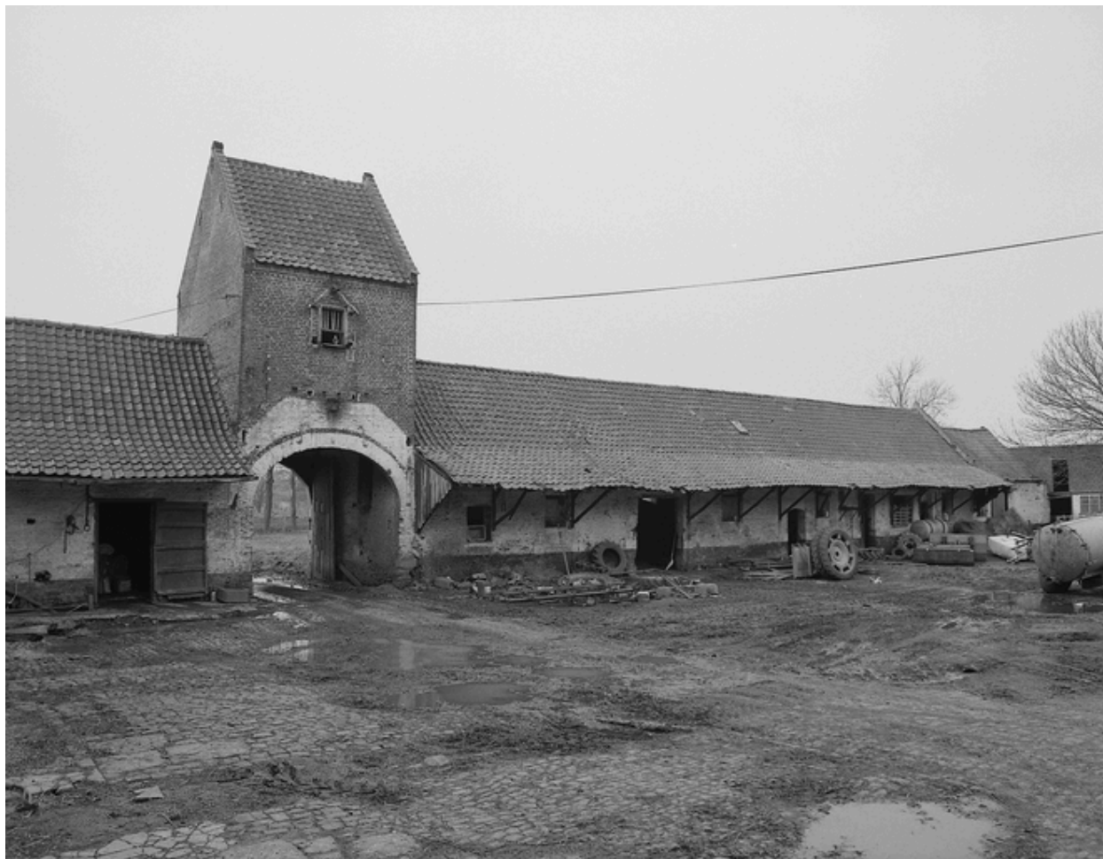
Vue générale des écuries et le pigeonnier-porche depuis la cour.
