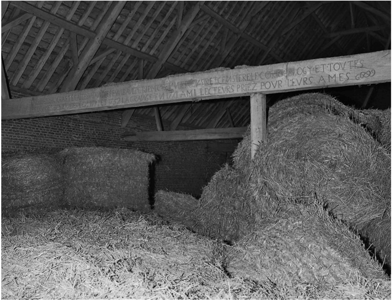
Vue générale de la poutre de la grange portant la dédicace de la construction.
