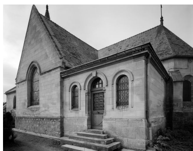
Élévation sud. Phot. Jean-Michel Perrin IVR22_19846001293V
