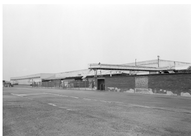
Vue de la partie sud de l'usine, occupée par les stocks. Phot. Thierry Lefébure IVR22_19960200123X
