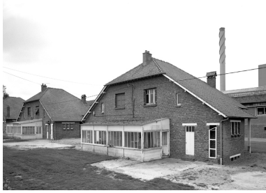
Elévation sur jardin d'une des maisons des cadres de l'usine. Phot. Thierry Lefébure IVR22_19960200576V
