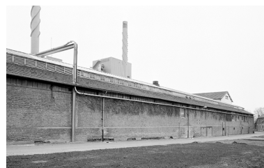
Elévation externe (est) du magasin général et de l'atelier de réparation. Phot. Thierry Lefébure IVR22_19960200130X
