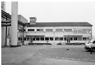
Elévation sud du laboratoire précédemment occupé par l'atelier de fabrication de biberons prêts à l'emploi. Phot. Thierry Lefébure IVR22_19960200129X
