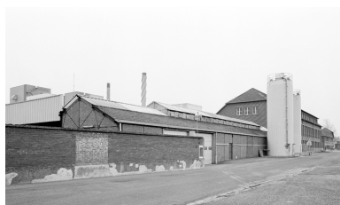
Vue du bâtiment social et d'un bâtiment à usage de remise et entrepôt, depuis le sud-ouest. Phot. Thierry Lefébure IVR22_19960200124X
