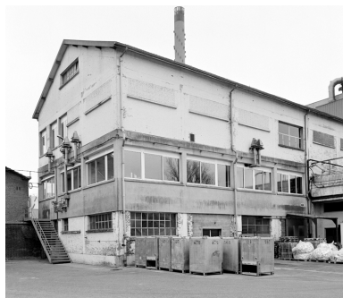
Vue partielle nord du laboratoire précédemment occupé par l'atelier de fabrication de biberons prêts à l'emploi. Phot. Thierry Lefébure IVR22_19960200131X
