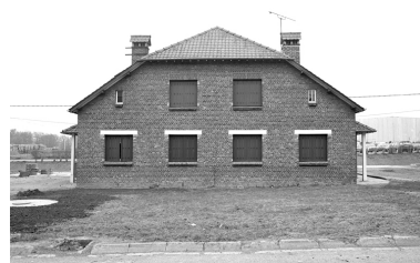
Façade d'une des maisons de la cité des cadres de l'usine, renfermant deux logements symétriques. Phot. Thierry Lefébure IVR22_19960200121X
