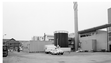
Partie sud-ouest de la cour de l'usine, occupée par la chaufferie, le réservoir de fuel et des stocks. Phot. Thierry Lefébure IVR22_19960200128X
