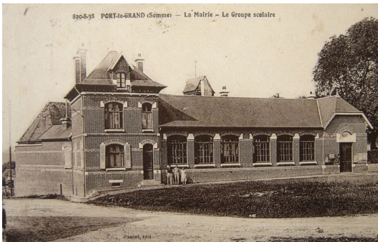
Carte postale présentant la nouvelle mairie-école juste après sa construction.
