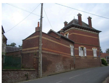
Vue latérale depuis la rue de la Somme. Phot. Inès Guérin IVR22_20068005382NUCA
