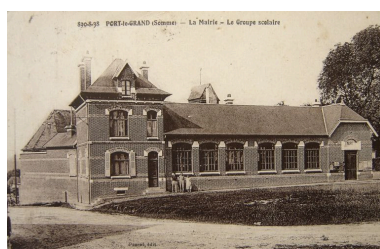
Carte postale présentant la nouvelle mairie-école juste après sa construction. Phot. Inès Guérin IVR22_20068005381NUCAB
