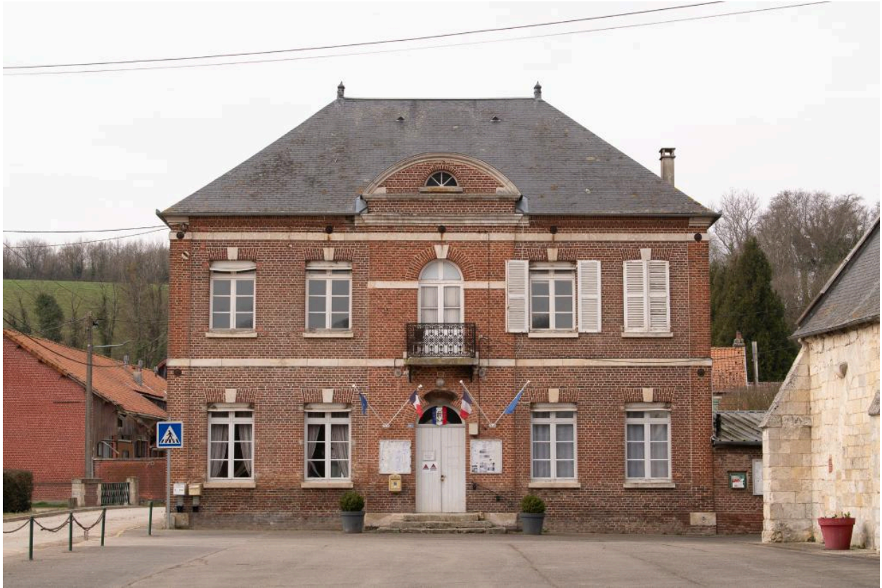
Mairie-école vue depuis l'est.
