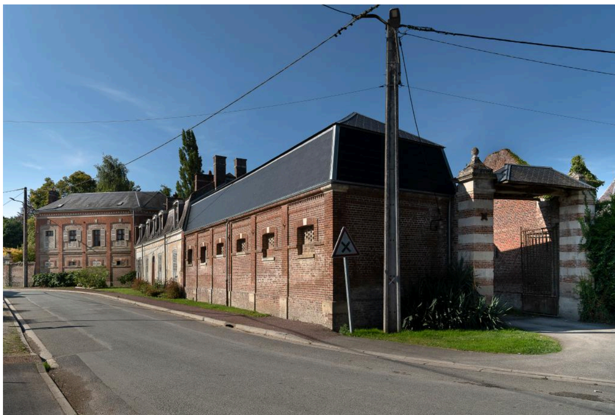
Vue générale depuis l'est de l'entrée de la ferme dite du chapitre avec bâtiment agricole, ancien logis et demeure en brique.
