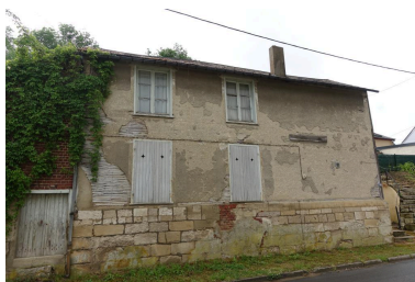
Ancienne agence postale vue depuis le nord-ouest, n°38 Grande Rue.
