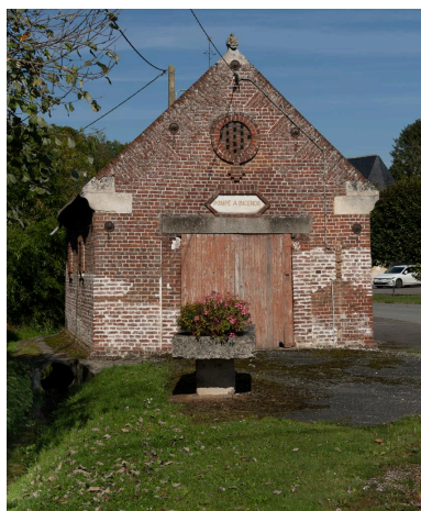
Vue générale de la façade sud du bâtiment des pompes à incendie.
