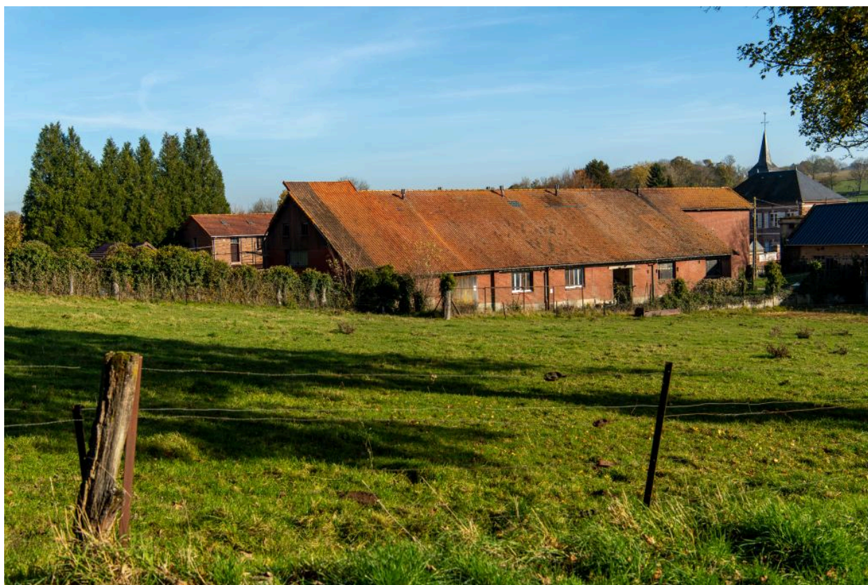
Vue générale depuis le sud des bâtiments techniques de l'ancienne laiterie.
