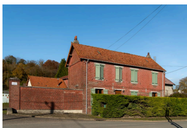
Logis de l'ancienne laiterie, vue depuis le sud-ouest, n°1 rue d'Empire.
