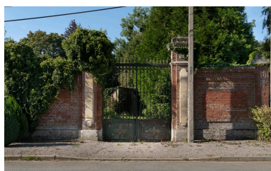
Vue générale depuis l'est du portail d'entrée de la demeure de la ferme dite du chapitre, n°5 rue saint-Cyr.
