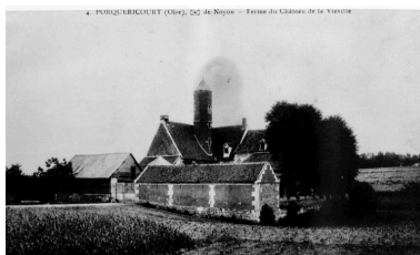
La ferme de la Viéville, avant 1914 (AP). Phot. Jean-Michel Périn IVR22_19856000159XB
