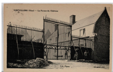
Vieffvillers (Oise). La ferme du château, carte postale, coll. Pigout [1er quart du 20e siècle] (coll. part.). Phot. Marc Kérignard IVR32_20226000085NUCA
