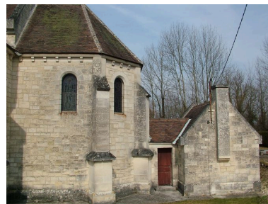
Détail du chevet. Phot. Irwin Leullier IVR22_20050200704NUCA
