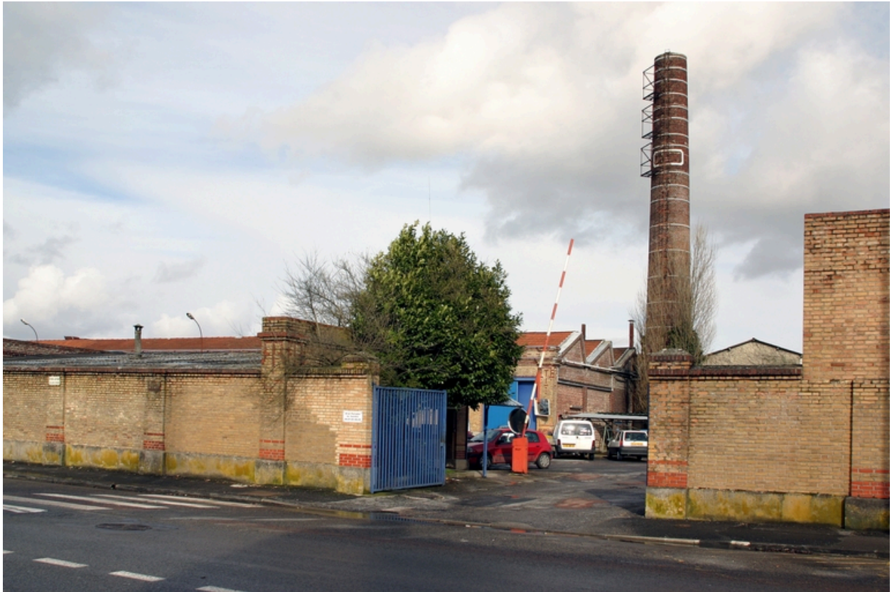
Entrée secondaire de l'usine.
