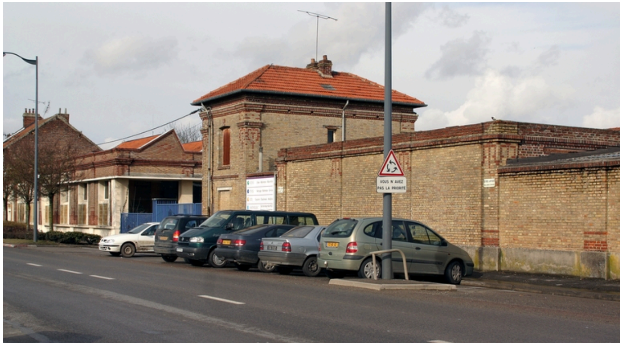
Entrée principale de l'usine.
