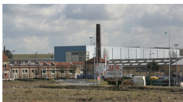
Vue générale de l'usine : à l'arrière-plan, les ateliers de 1969. Phot. Frédéric Pillet IVR22_20060205213NUCA
