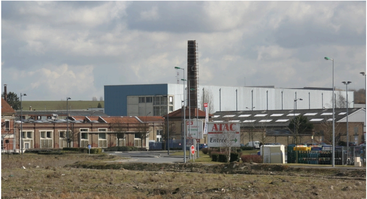
Vue générale de l'usine : à l'arrière-plan, les ateliers de 1969.
