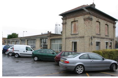
Conciergerie et atelier d'entretien. Phot. Frédéric Pillet IVR22_20060205219NUCA
