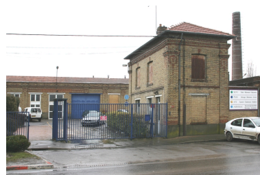
Entrée principale : à droite la conciergerie, au fond les ateliers de 1920. Phot. Frédéric Pillet IVR22_20060205217NUCA
