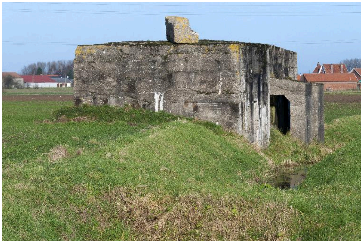
Vue de trois-quarts, vers le nord-ouest
