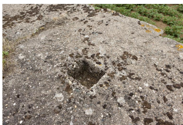
Couvrement, détail d'un conduit de cheminée obstrué Phot. Jean-Marc Ramette IVR31_20145905266NUCA
