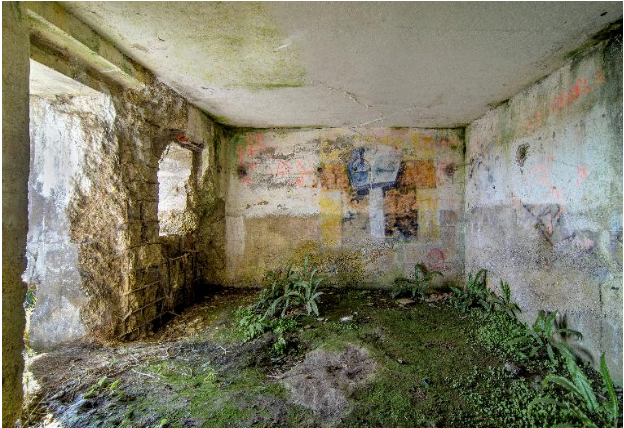
Vue intérieure de la première salle (au sud)
