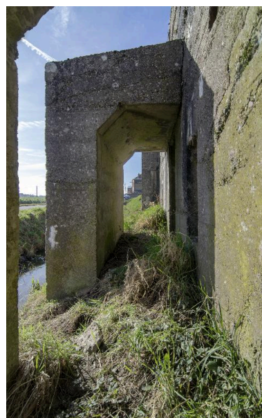
Vue en enfilade au travers des porches pare-souffle Phot. Jean-Marc Ramette IVR32_20165901120NUCA
