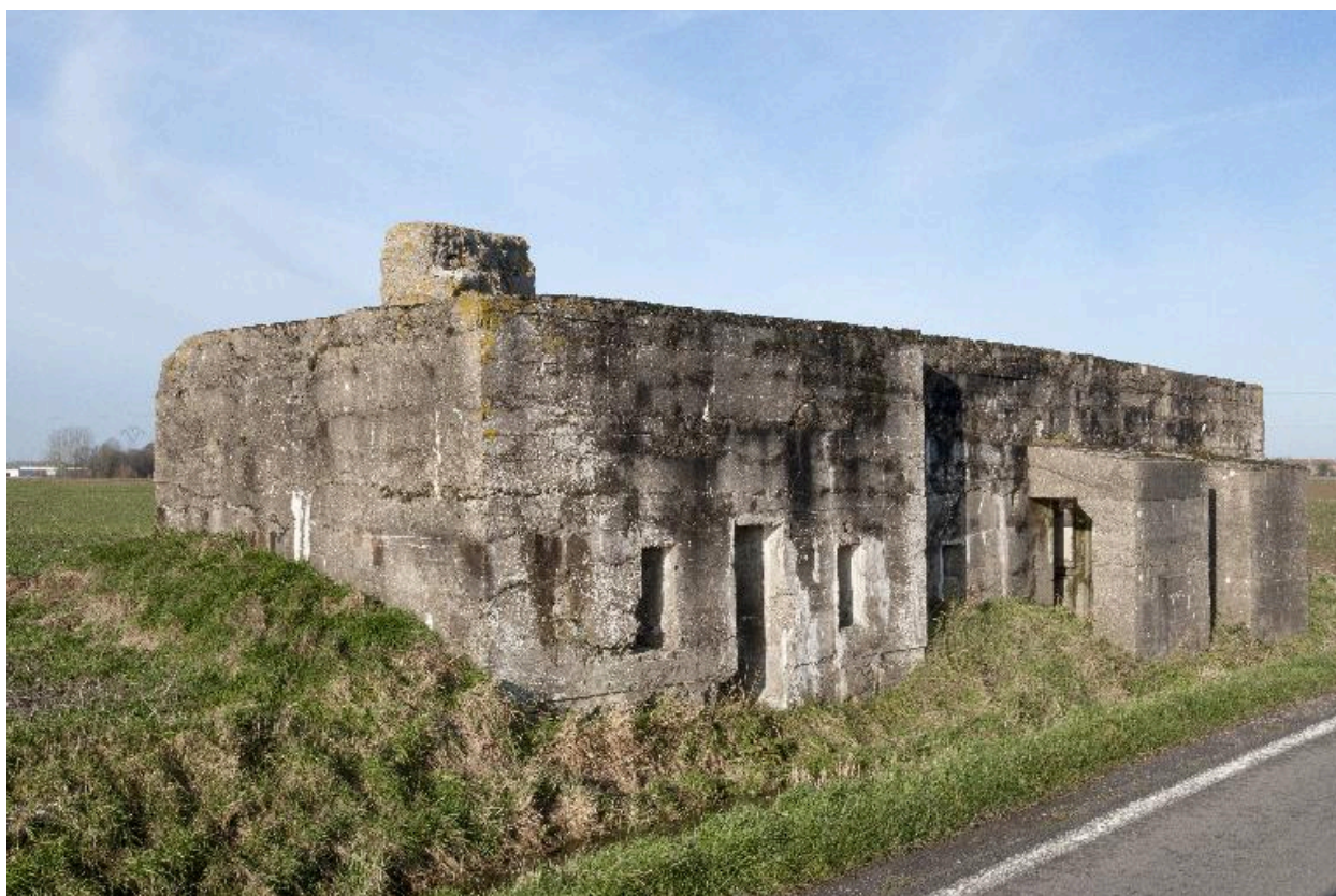
Vue de trois-quarts vers le nord-ouest
