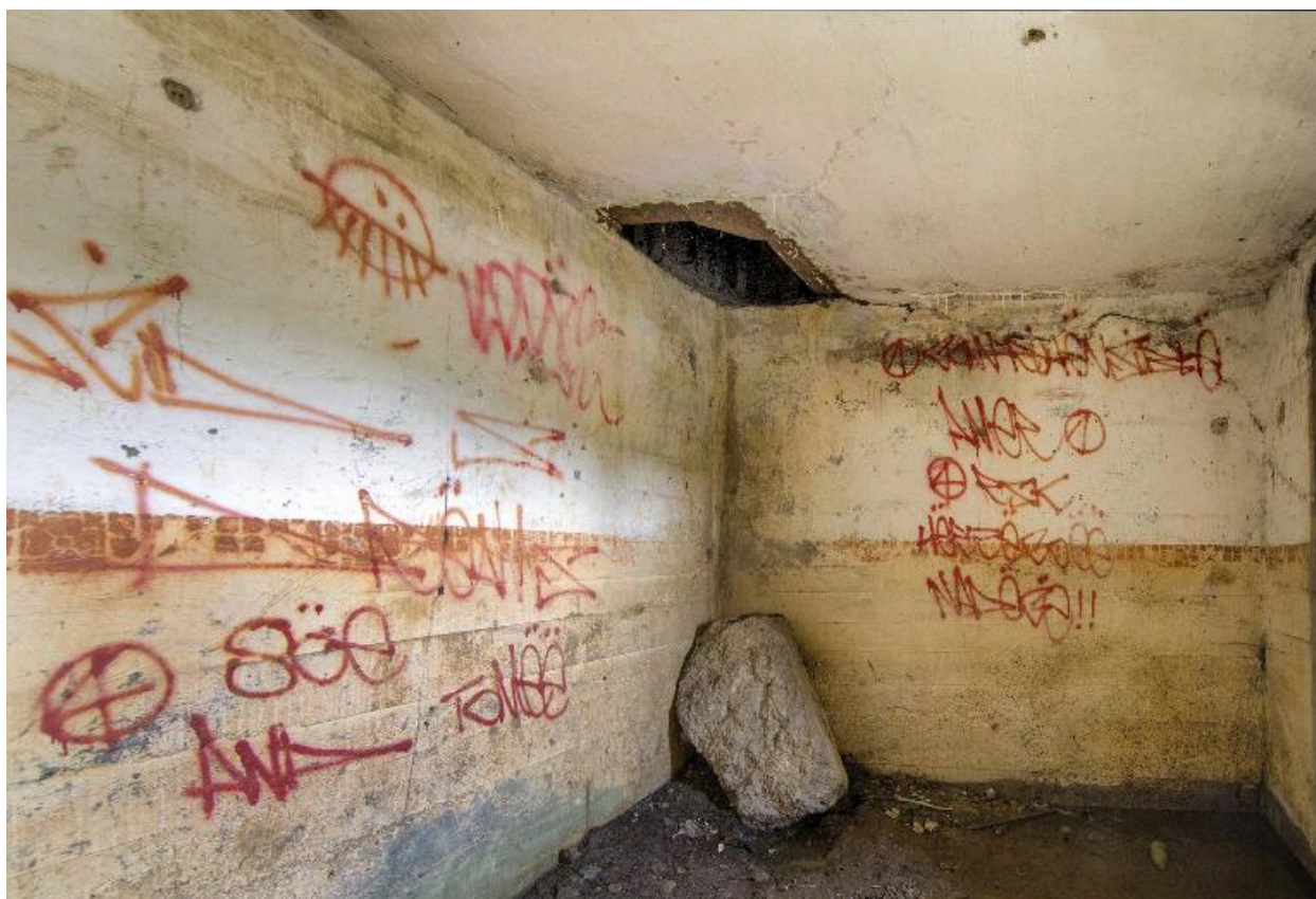
Vue au grand angulaire de la seconde salle (sud) avec, à l'angle supérieur gauche, l'accès à l'observatoire cuirassée
