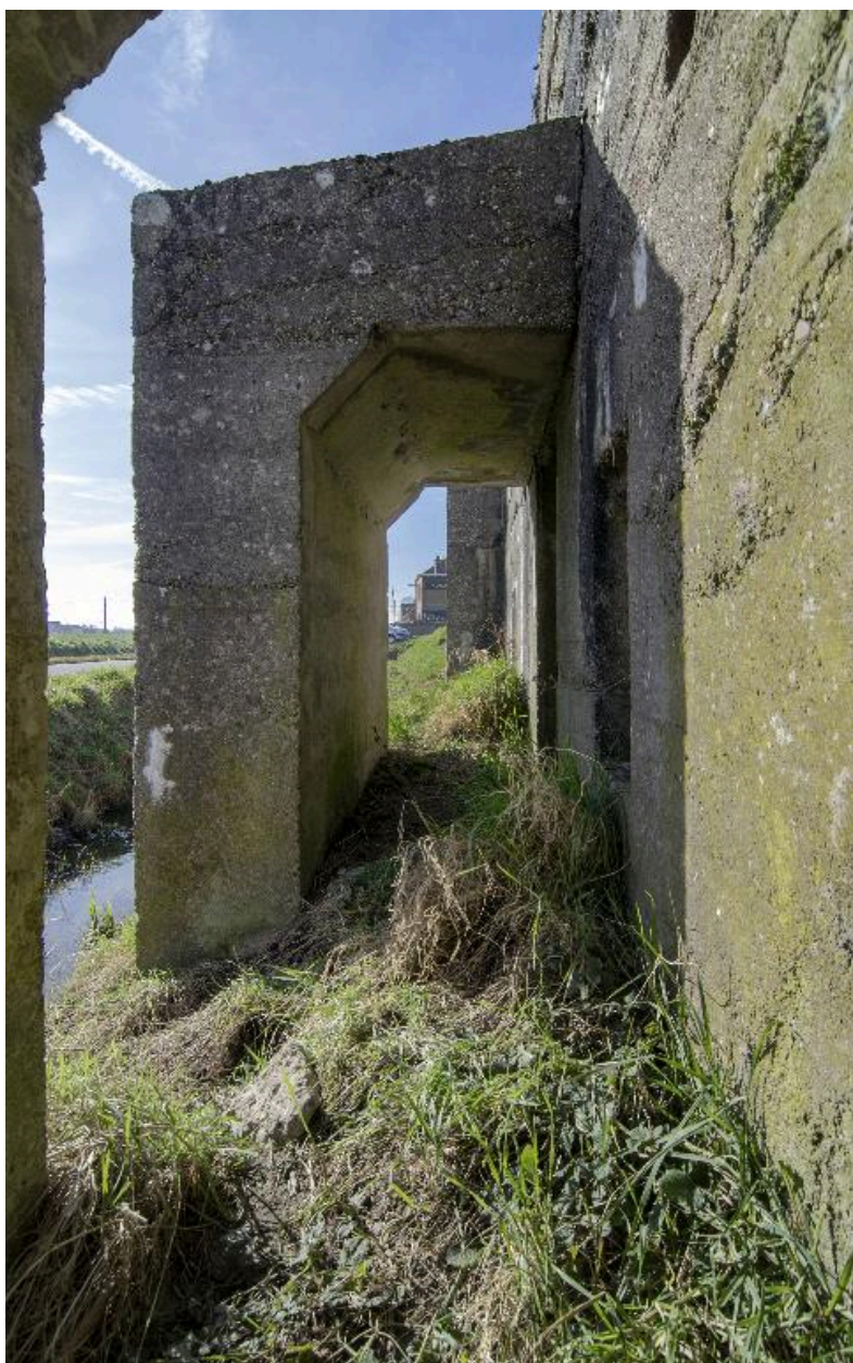
Vue en enfilade au travers des porches pare-suffle
