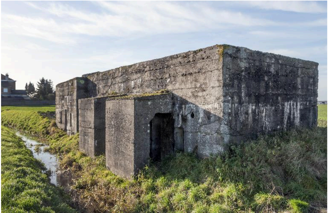
Elévation antérieure vue de trois-quarts vers le sud-ouest
