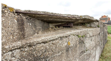
Elévation ouest : Large embrasure de surveillance en direction du front Phot. Jean-Marc Ramette IVR31_20145905270NUCA
