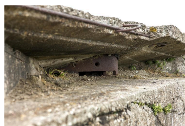
Elévation ouest : détail de l'observatoire cuirassé dans son embrasure Phot. Jean-Marc Ramette IVR31_20145905269NUCA
