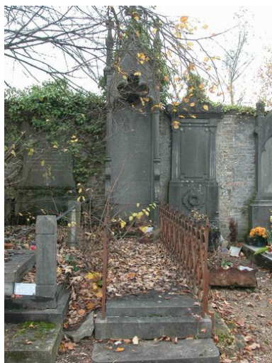
Vue générale. Phot. Laurent Nicolas IVR22_20048001254NUCA
