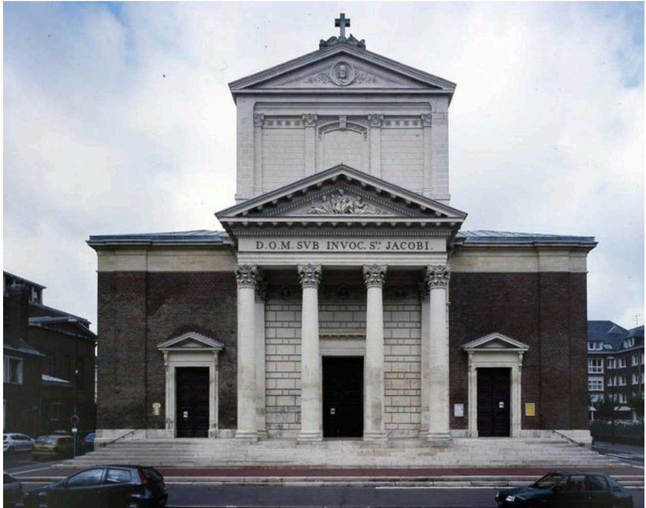
Eglise Saint-Jacques, façade antérieure.
