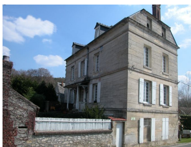
Vue d'ensemble. Phot. Bertrand Fournier IVR22_20046002887NUCA
