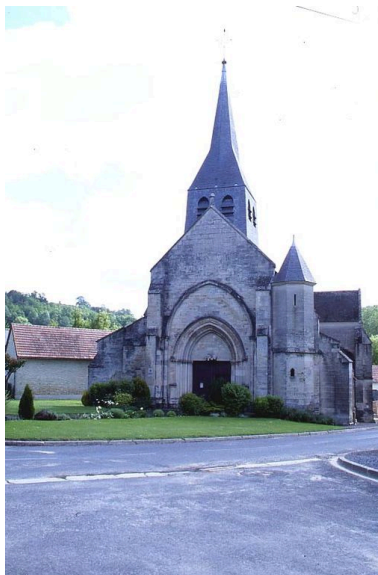
Vue de la façade ouest. Phot. Inès Guérin IVR22_20030203253NUCA
