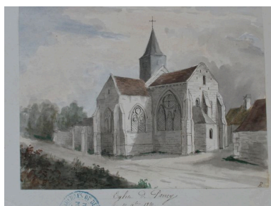
Dessin de l'église avant la guerre, par Amédée Piette (AD Aisne : 8 Fi Pancy 1).
