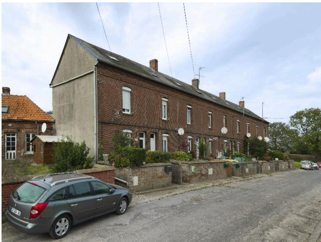
Vue de trois-quarts depuis la rue de Méneslies.
