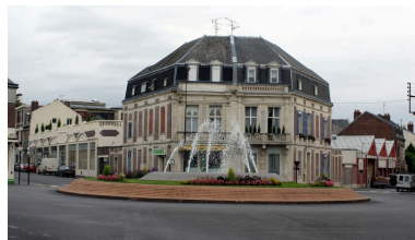
Les ateliers vus depuis la place de Mulhouse : à gauche ceux de la rue de Bellevue, à droite ceux de la rue Condorcet. Phot. Frédéric Pillet IVR22_20040200719NUCA
