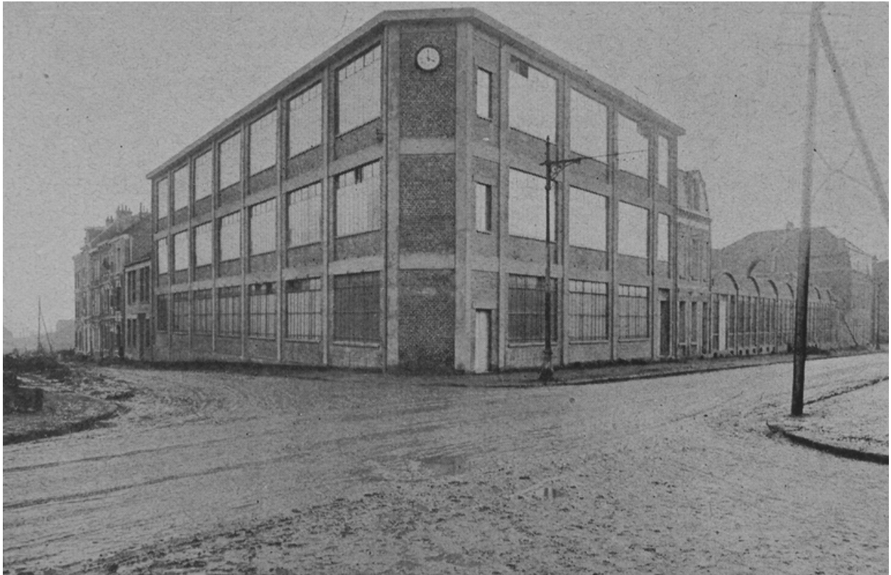
Façade de l'usine à l'angle de la rue de Bellevue et de la rue Pierre-Ramus, après les travaux de reconstruction, vers 1920-1922 (Le Monde Illustré).
