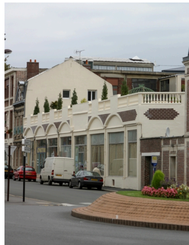
Façade des ateliers, rue de Bellevue. Phot. Frédéric Pillet IVR22_20040200720NUCA
