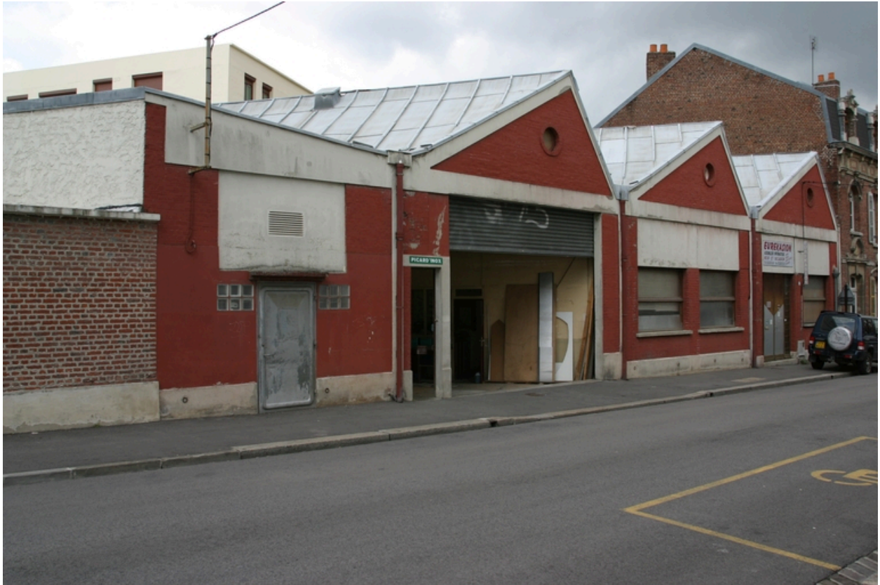
Façade des ateliers, rue Condorcet.
