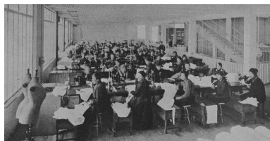
Vue intérieure de l'atelier de confection après la reconstruction, vers 1920-1922 (Le Monde Illustré). Phot. Pillet Frédéric IVR22_20040200611NUCAB
