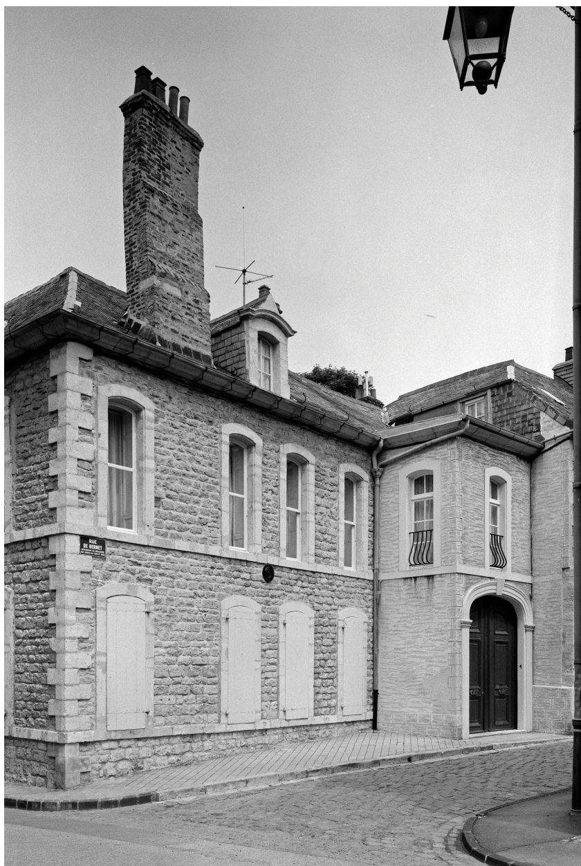
Vue de profil sur rue de Bernet.
