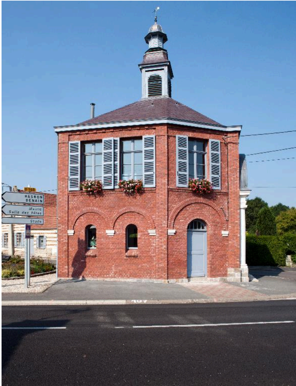
Vue de la façade de la mairie.
