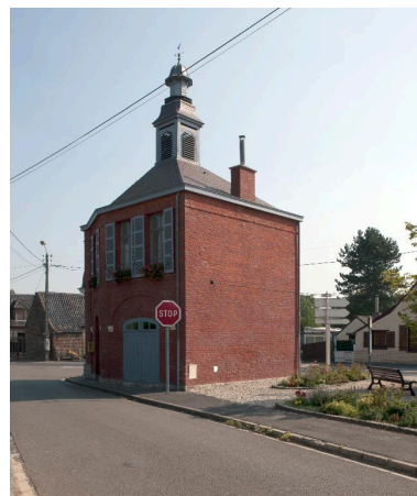
Vue de trois quarts : façade de la mairie et élévation postérieure. Phot. Pierre Thibaut IVR31_20125902160NUCA
