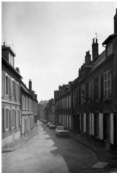
Façade sur voie. Phot. Jean-Michel Périn, Phot. Éric Dessert IVR31_19806203076X
