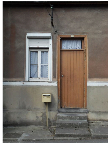
Détail d'un logement. Phot. Isabelle Barbedor IVR22_20108001514NUCA
