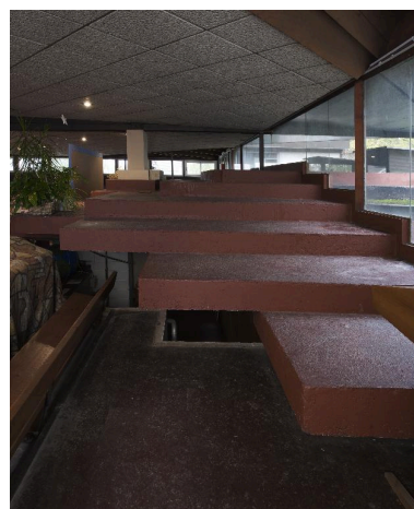
Vue de la dalle de couverture à gradins en suspens. Phot. Thierry Lefébure IVR32_20170200395NUC2AQ
