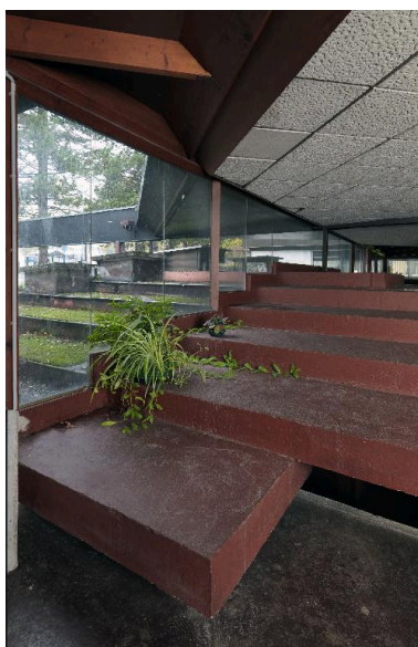
Vue de la dalle de couverture à gradins, au nord. Phot. Thierry Lefébure IVR32_20170200394NUC2AQ
