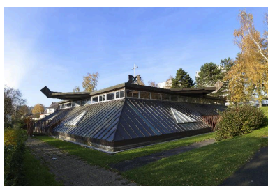
Vue générale depuis le sud-est. Phot. Thierry Lefébure IVR32_20170200373NUC2AQ
