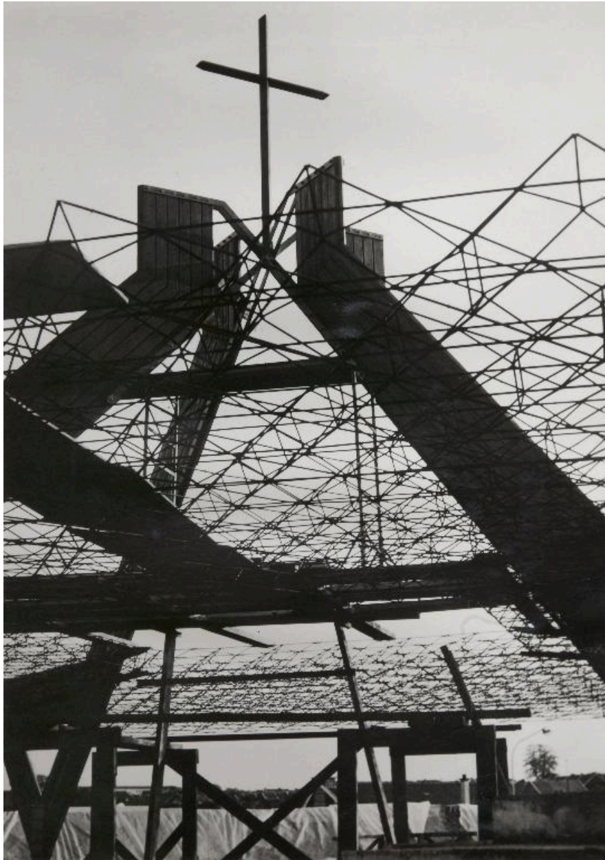
L'édifice en cours de construction. Vue de la charpente et de la résille en métal. Photographie, vers 1970. AP Jean XXIII, Saint-Quentin.
