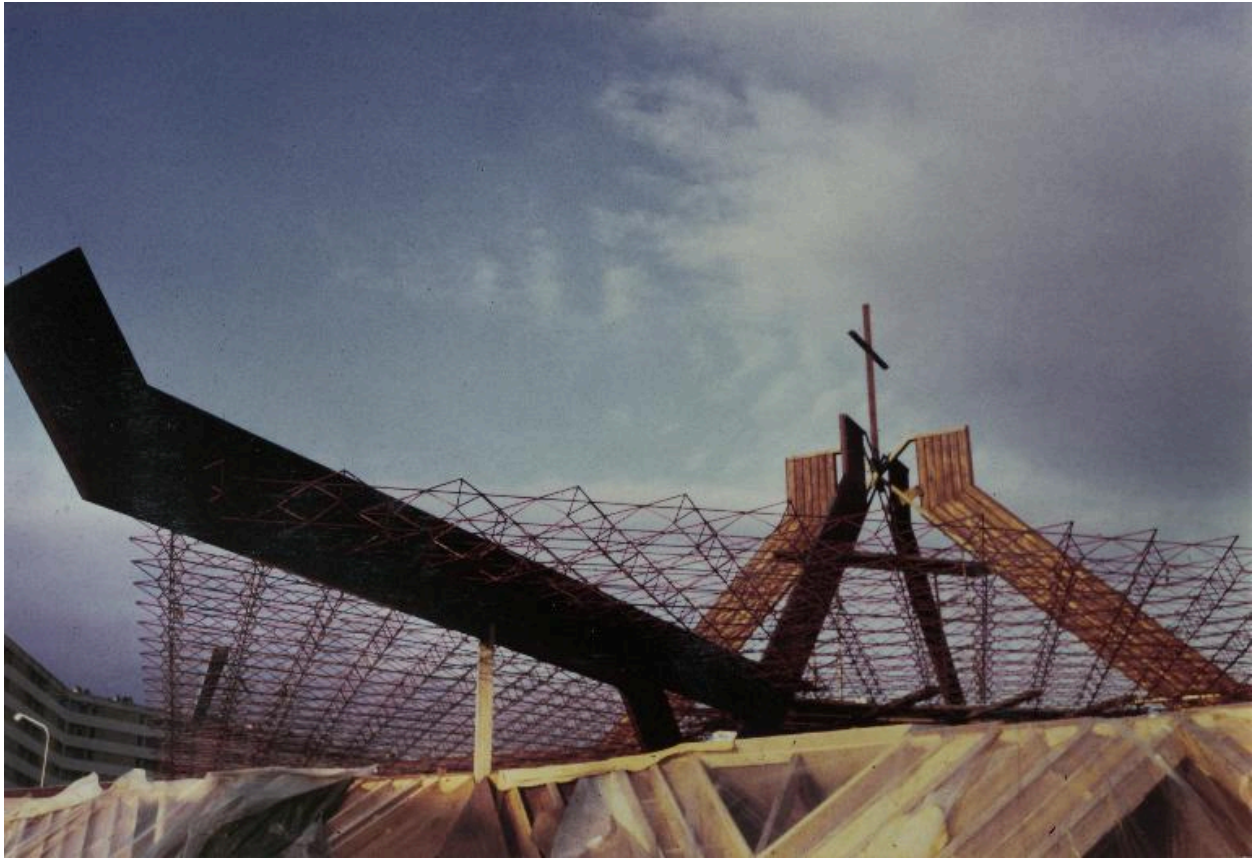
L'édifice en cours de construction. Vue de la charpente et du clocher horizontal. Photographie, vers 1970. AP Jean XXIII, Saint-Quentin.
