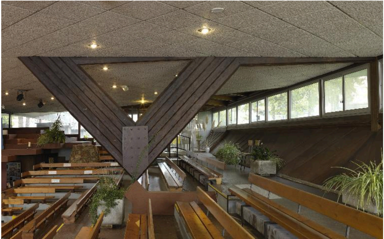
Vue de détail de la charpente en bois lamellé-collé.
