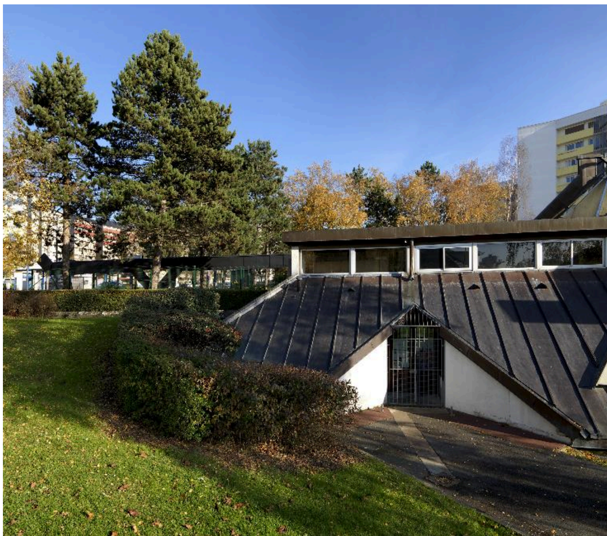
Vue de l'entrée au niveau inférieur.
